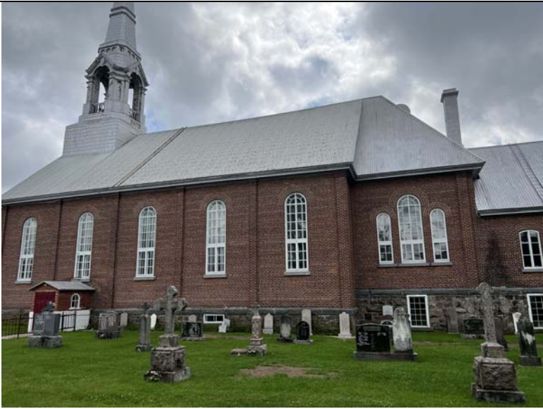
Élévation latérale (nord-ouest)
