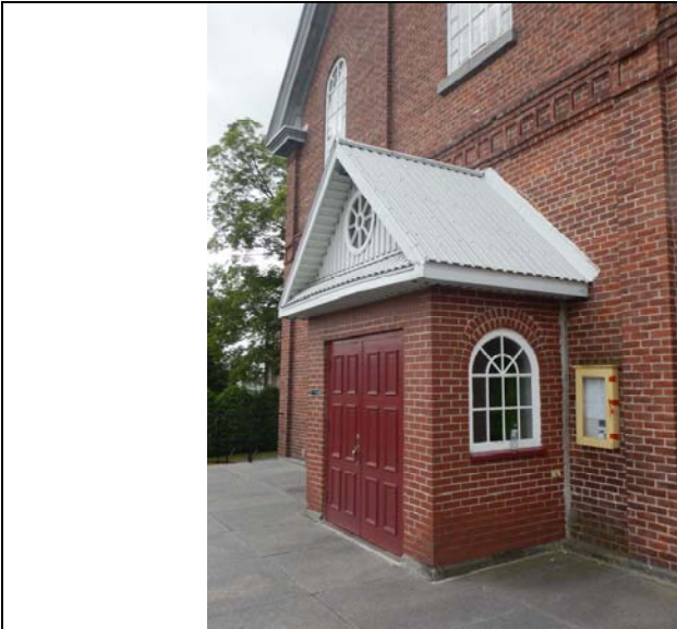
Vestibule de l'entrée principale
