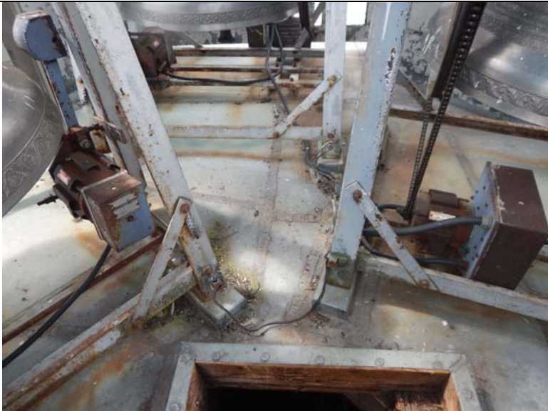
Détail du plancher des cloches
