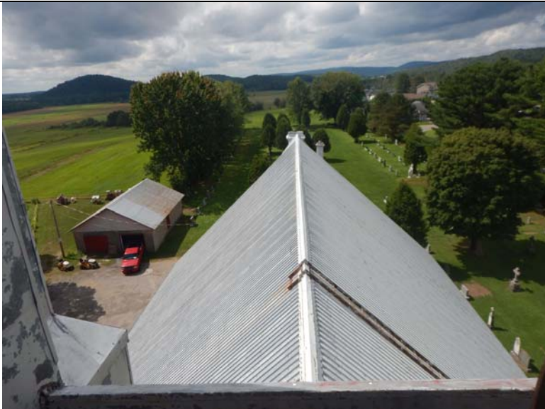
Vue de la toiture principale
