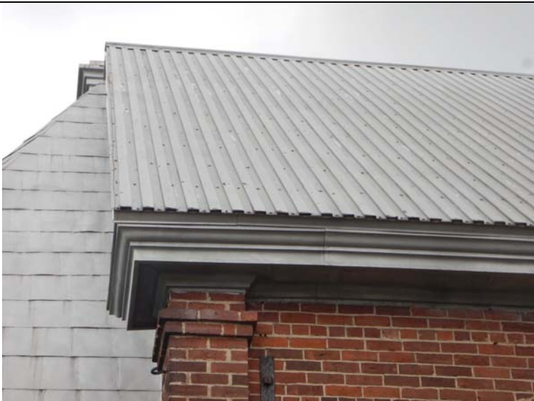
Détail de toiture avec tôle de profilé industriel – et vue de la tôle à la canadienne de la toiture de la petite chapelle
