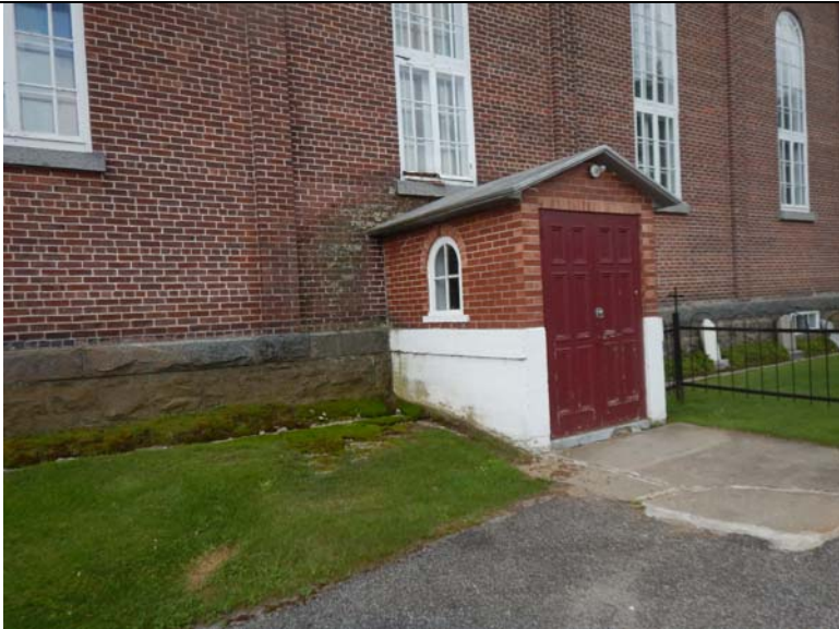
Vestibule d'issue de la salle du sous-sol
