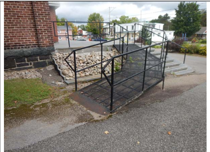
Rampe pour Handicapés
