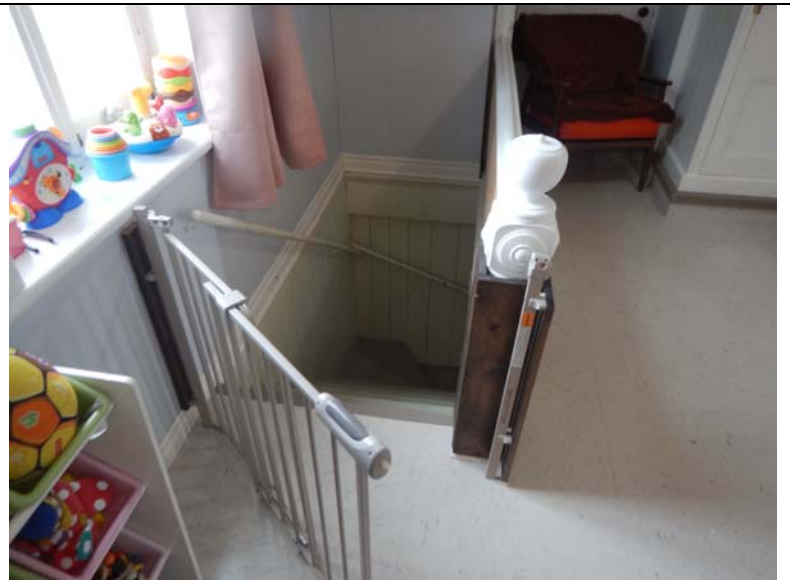
Escalier d'accès au sous-sol
