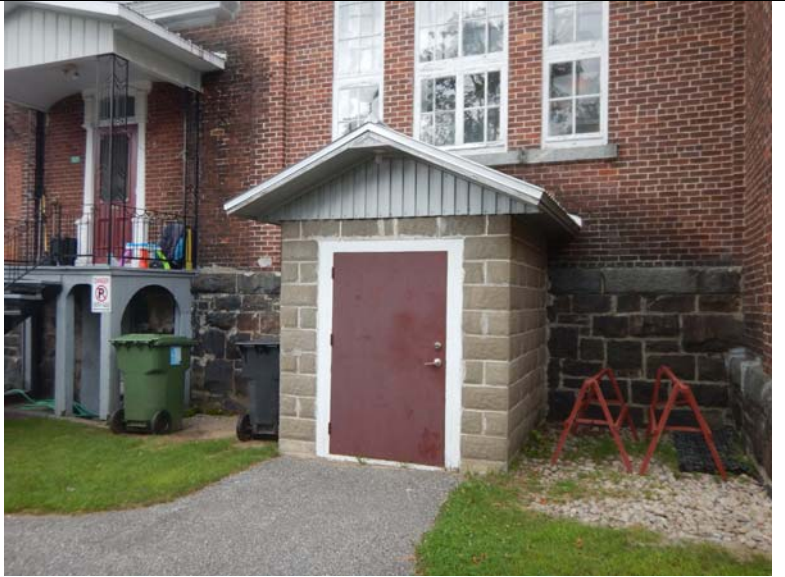
Vestibule d'issue de la salle au sous-sol
